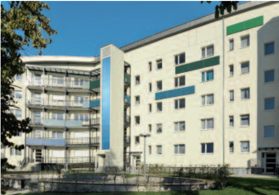
▼ Ansicht nach der Modernisierung
